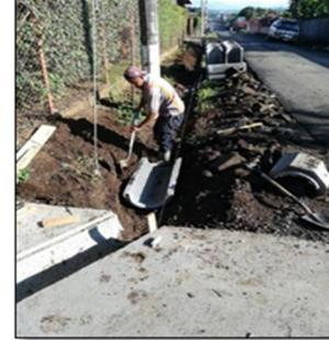
11 **Colocación de tubería de concreto de 18 pulgadas**
