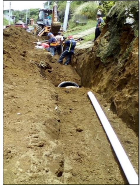
16 Colocación de tubería de concreto de 30 pulgadas
